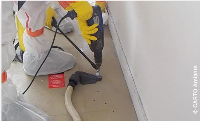
(maintien de l'embout au droit du perçage, entretien pour éviter le colmatage des résidus à l'entrée du tuyau). La protection collective du processus est complétée par une humidification préalable du matériau.
